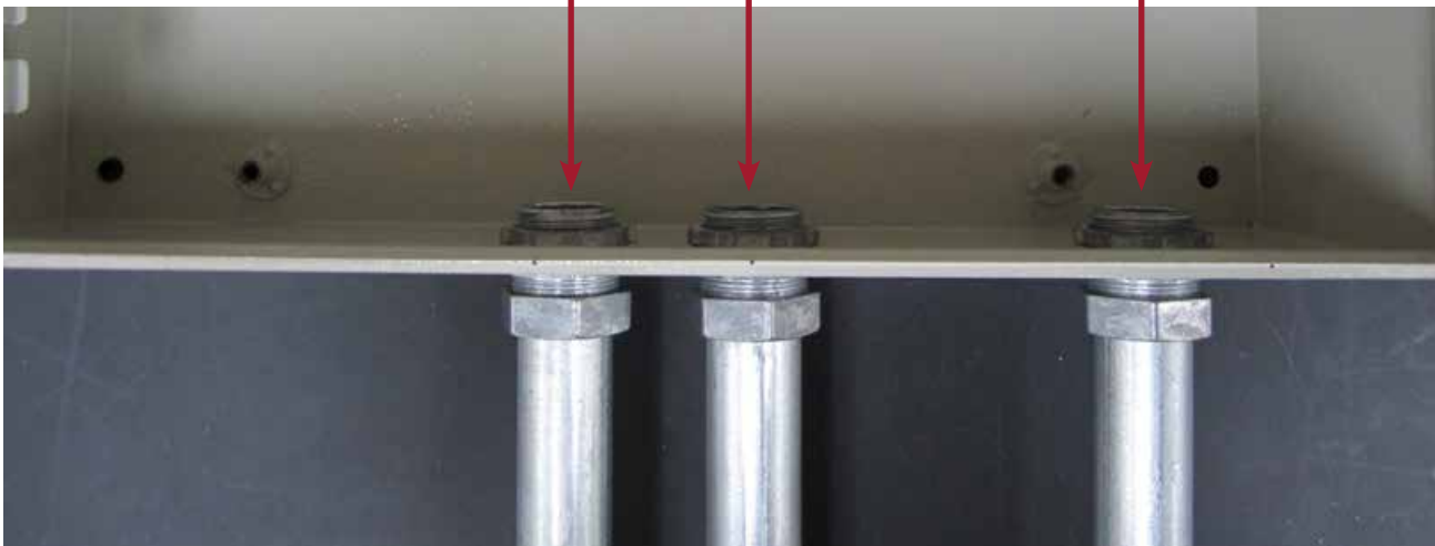
Abbildung 3: Beispiel für fertige Durchführungen
